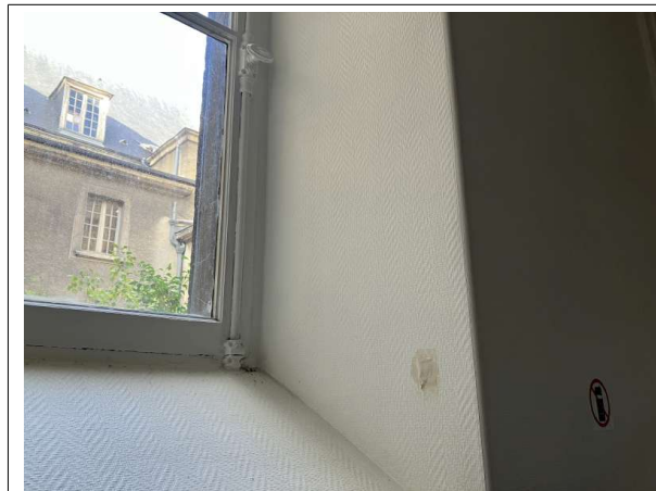
Prélèvement - P235 : Patio 2 / Façade Sud / Rez-de-Chaussée / Circulation - Enduit- (Absence d'amiante)
