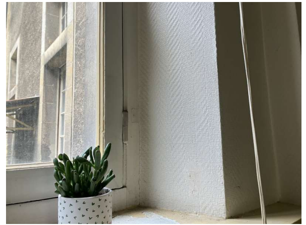
Prélèvement - P165 : Patio 2 / Façade Est / Rez-de-Chaussée / Local 3 - Enduit- (Absence d'amiante)
